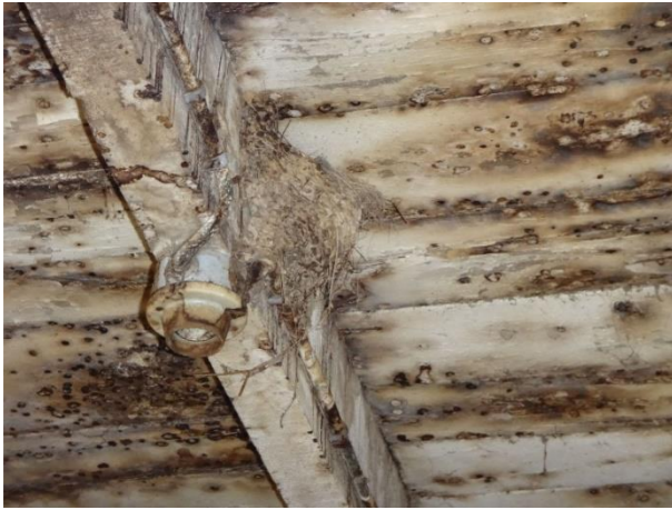
Photo 1 : Nid d'hirondelle rustique dans l'ancienne salle de traite
